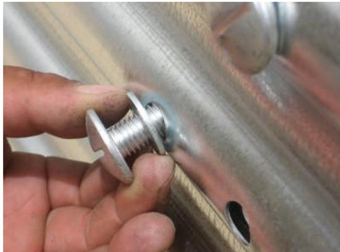
использована на должном уровне колец. Когда вкладыш закреплён верёвкой, **крючки** необходимо разместить внизу конечного кольца панелей через болт. После того, как все кольца размещены, снова проверьте, что ёмкость полностью круглая и закрутите все болты и гайки. Болты и гайки **не подходят** для отверстий **верхнего уровня**.
