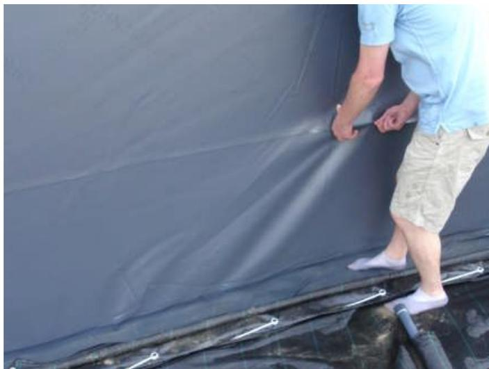
Вес и давление воды будет удерживать вкладыш в углах. Как только это будет сделано, частично заполните начальный котлован вокруг ёмкости песком или илом для удержания бокового давления воды наполняющей ёмкость. Не заполняйте котлован полностью, потому что ёмкости необходимо время и место для усадки.
