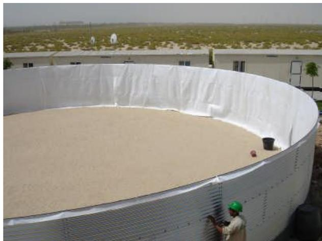
3. Войлок поставляется с шириной 5,25 и длиной в соответствии с заказанной ёмкостью. Выложите куски утеплителя сверху ёмкости и закрепите их с помощью вложенными хомутами. Работайте по кругу ёмкости выкладывая войлок с нахлестом в 25 см., до момента пока металлическая поверхность не закончится. Убедитесь, что защитный войлок хорошо лежит без каких либо загибов.
