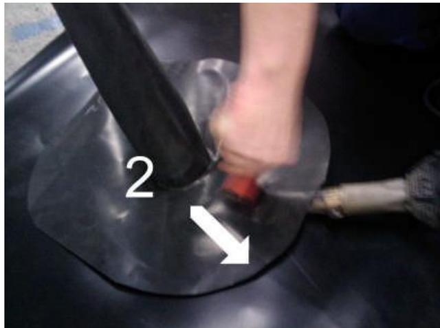
Повторите это с рюгой стороны выхода (3). Вконец пройдитесь валиком и горячим воздухом вокруг трубы для лучшего схватывания клея (4).
