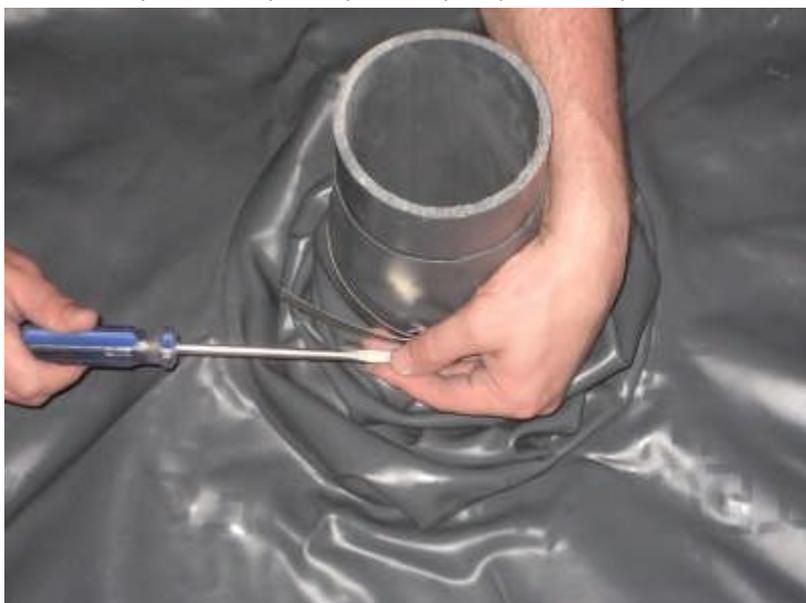
6. Вконец полностью обмотайте конструкцию с помощью ПВХ ленты (в комплекте).
