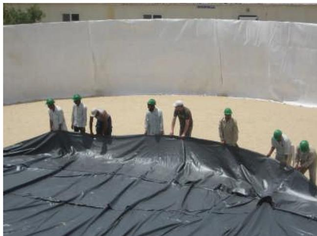
3. Подайте край вкладыша изнутри ёмкости человеку, который снаружи ёмкости и зафиксируйте вкладыш хомутами. Край вкладыша должен быть приблизительно на 30 см больше чем край ёмкости.
