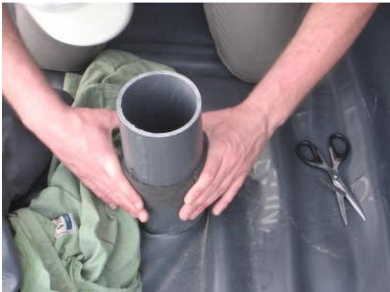
3. Плотно затяните вход/выход вокруг трубы и отрежьте лишний кусок входа/выхода.
