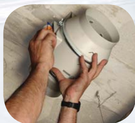
Установите корпус вентилятора
