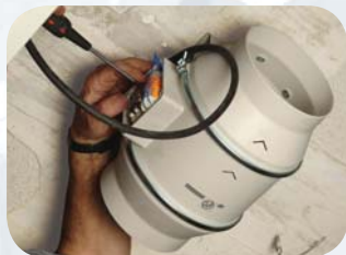
Подключите вентилятор к сети электропитания
