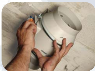
Установите блок двигатель-крыльчатка
