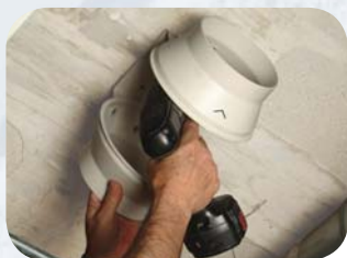
Закрепите основание вентилятора
