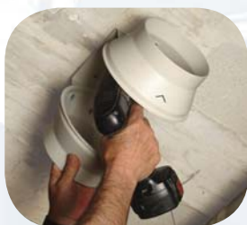
Закрепите основание вентилятора
